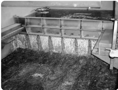
Durch den Wasserdruck wird das Spülschild geöffnet.
