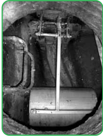
Anlage bei Trockenwetter
