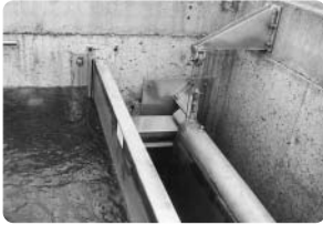
RÜ/Stauschild kurz vor Erreichen des max. Stauziels
