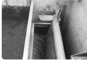
RÜ/Stauschild bei Erreichen des max. Stauziels (Entlastungsfall)
